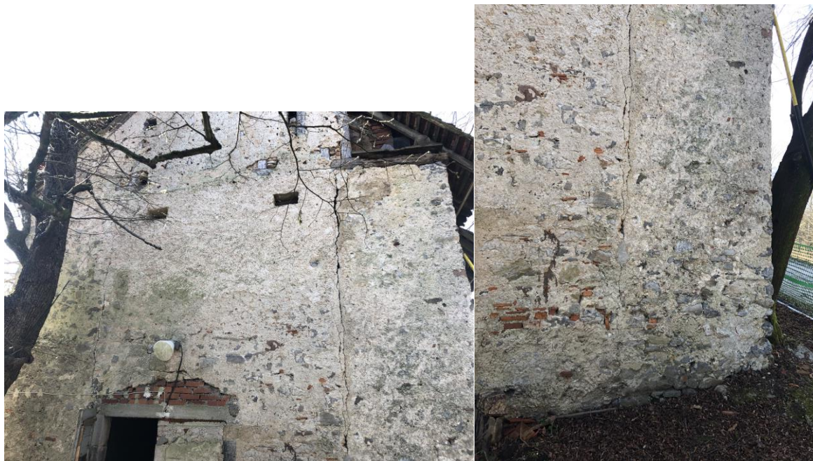
Razslojevanje primarnih slopov in »polnilnega« zidovja
