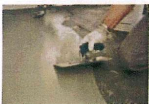
Po popolni osušitvi prvega premaza ali po 24 ur-ah izvedba drugega nanosa premaza pravokotno na prvega lahko z gladilko. Skupna deb. nanosa HIDROSTOP ELASICA mora biti min. 2-3 mm.
